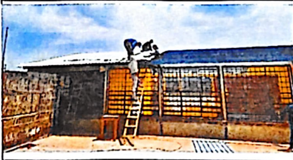
Foto 1: DURANTE EL CAMBIO DE TECHO
