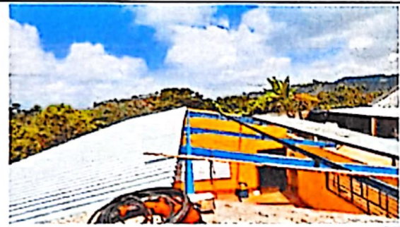
Foto 2: DURANTE EL CAMBIO DE TECHO
