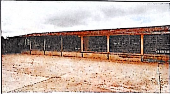
Foto 1: ANTES DE MANTENIMIENTO
