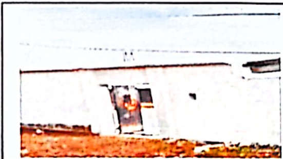
Foto 6: MURO Y REPELLO CONCLUIDO
