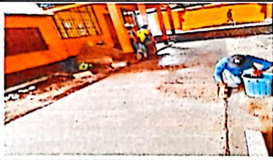
Foto 4: DURANTE LA EJECUCION DE LA OBRA
