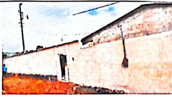
Foto 5: MURO Y REPELLO CONCLUIDO
