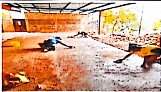
Foto 3: DURANTE LA EJECUCION DE LA OBRA
